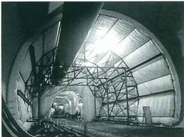
コンクリート養生全景（赤岩トンネル）
