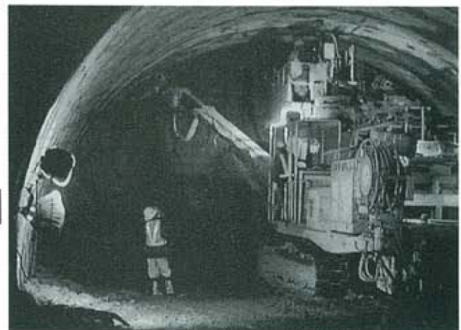
写真2 鋼製支保工建込み状況
