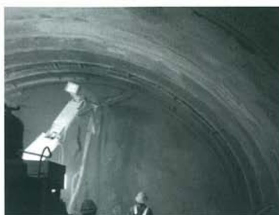
写真-2 EPショット工法の施工状況
