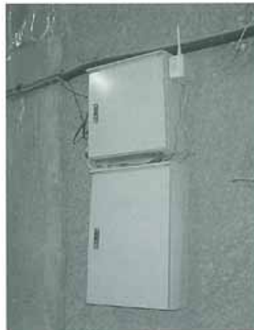
写真-4 基地局の設置状況
