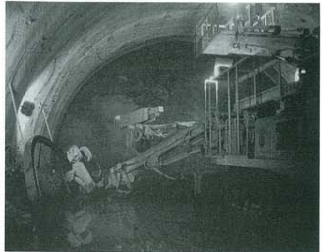
写真1 一次吹付及び鏡吹付状況
