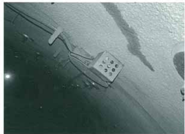
写真-2 KWS内蔵の発破防護取り付け状況
