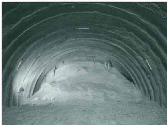
写真－1 切羽設置状況 (天端：赤色、左側壁：黄色、右側壁：青色)
