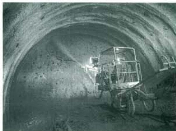
AFK-777J を用いた吹付け状況
