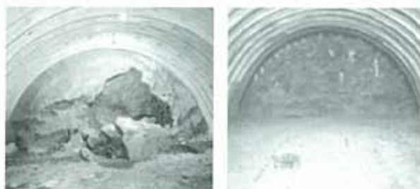
(FIT 工法施工前)
